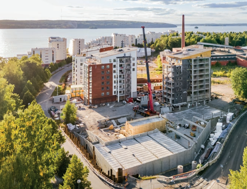
Varte Lahti rakentaa Lahden Ruoriniemen alueelle kolme asuinkerrostaloa ja pysäköintihallin.
