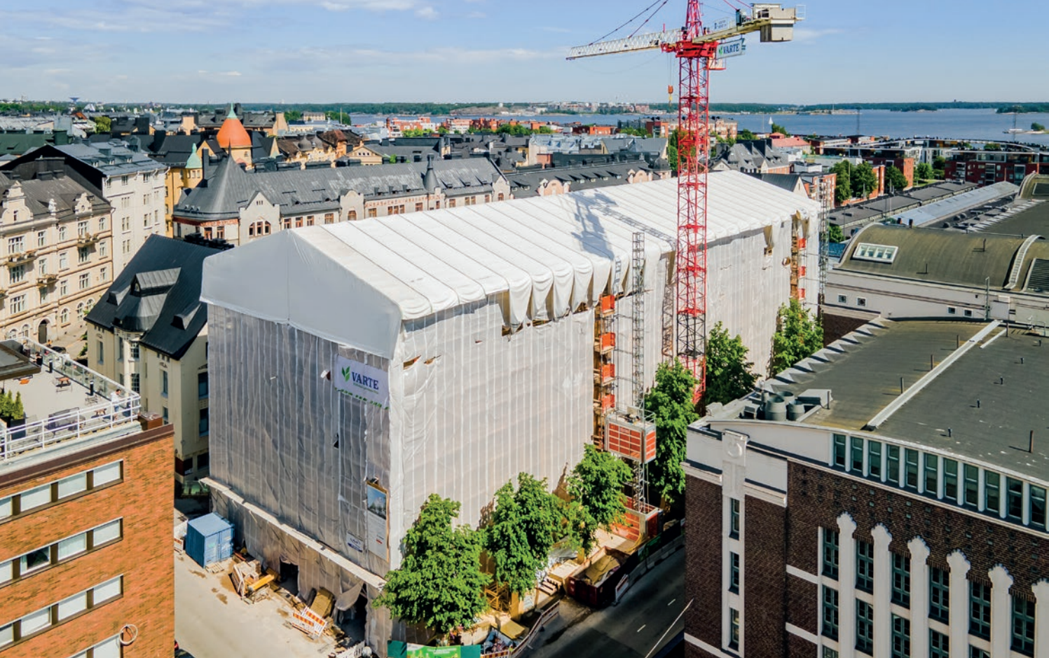
Työmaa: Kanavakatu 3, Helsinki
