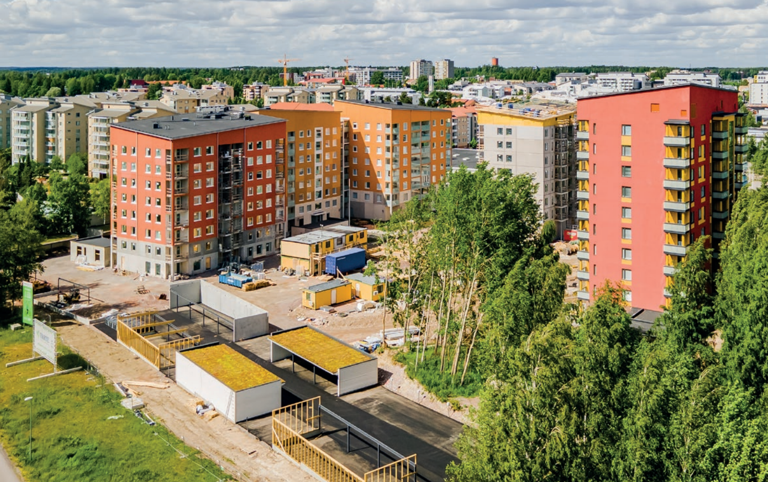
Työmaa: Palopellonkatu 6-10, Kerava
